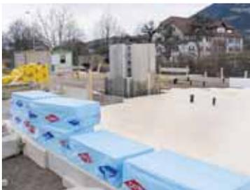
Die Bodenplatte wird unten mit 8 cm starken XPS Platten gedämmt
