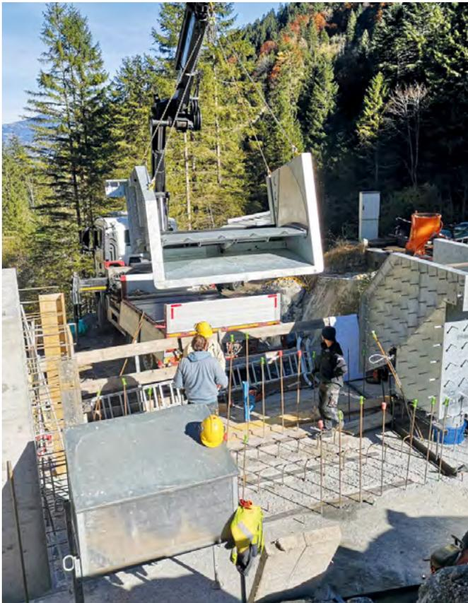
Versetzen der neuen hydraulischen Stauklappe in die Wildbachsperre
