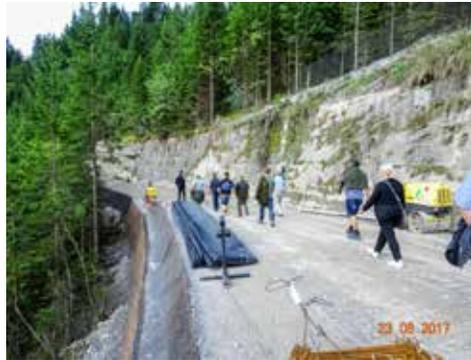
Die Zufahrtsstraße, ausgeführt als geotextil-artermierter Erdkörper, stützt in Zukunft den Fuß der Betonsperre.
