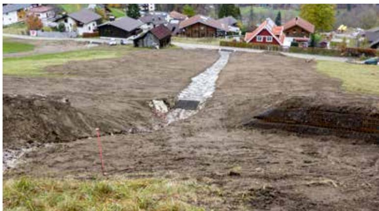
Leitdämme links und rechts der Flutmulde verhindern ein Ausbrechen des Hochwassers bzw. Geschiebes.
