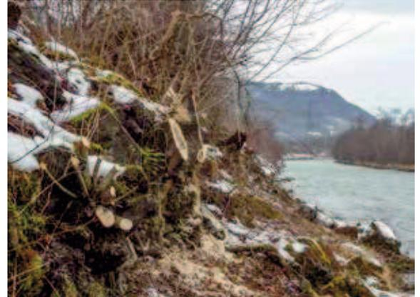
Ein freigeschnittener Abflussquerschnitt verbessert den Hochwasserabfluss.
