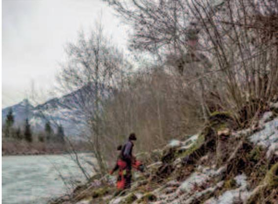
Jungwuchs wird entfernt, er behindert den Hochwasserabfluss.
