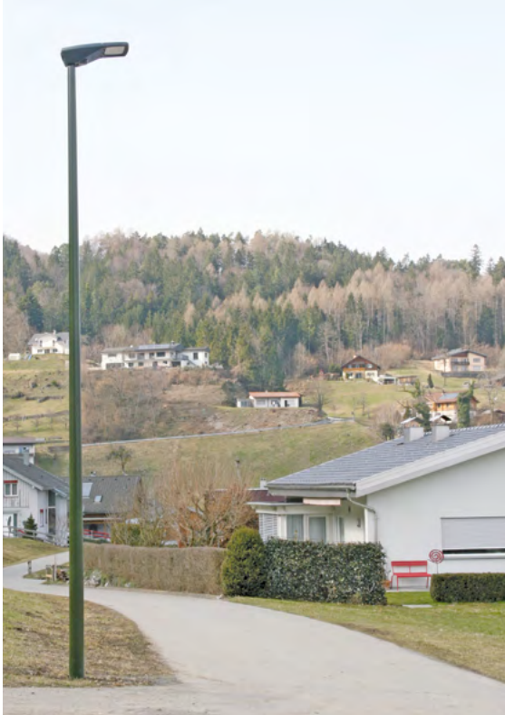
Alle neuen Straßenbeleuchtungen werden mit LED-Lampen ausgeführt.
