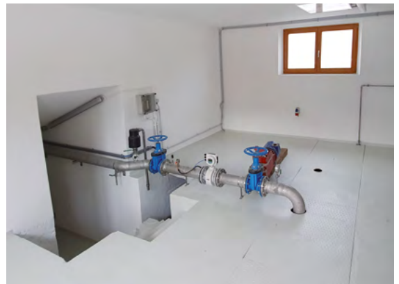
Das Gebäudeinnere erstrahlt in neuem Glanz.
