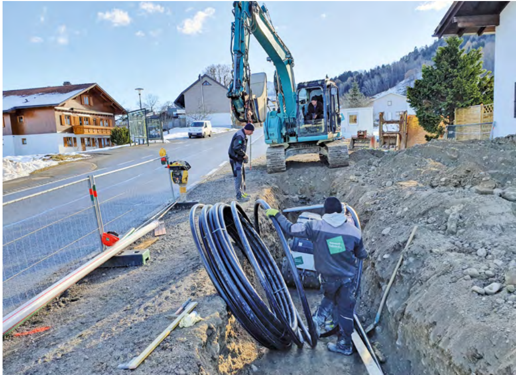
Fortsetzung der Kanalisierung in Halden
