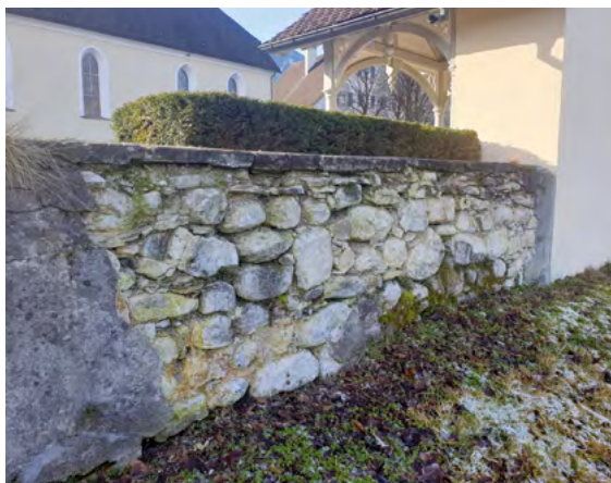
Bereits im Vorfeld wurde dieses Versuchsfeld freigelegt.
