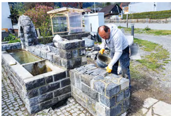
Instandsetzung des Brunnens beim Kreuzpark
