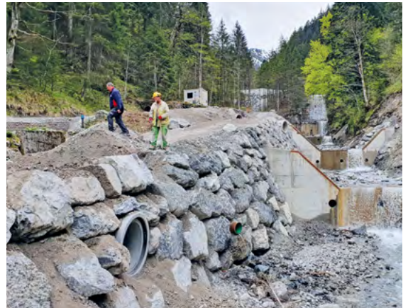
Zur Absicherung der Quelle und des Wegs muss das Ufer der Galina mit einem schweren, teilweise in Beton versetzten Steinsatz gesichert werden.
