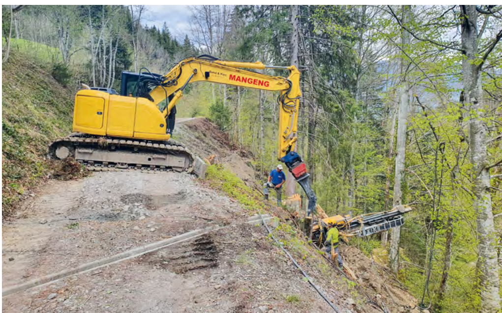
Ankerungsarbeiten durch die Wildbach- und Lawinerverbauung Vorarlberg.
