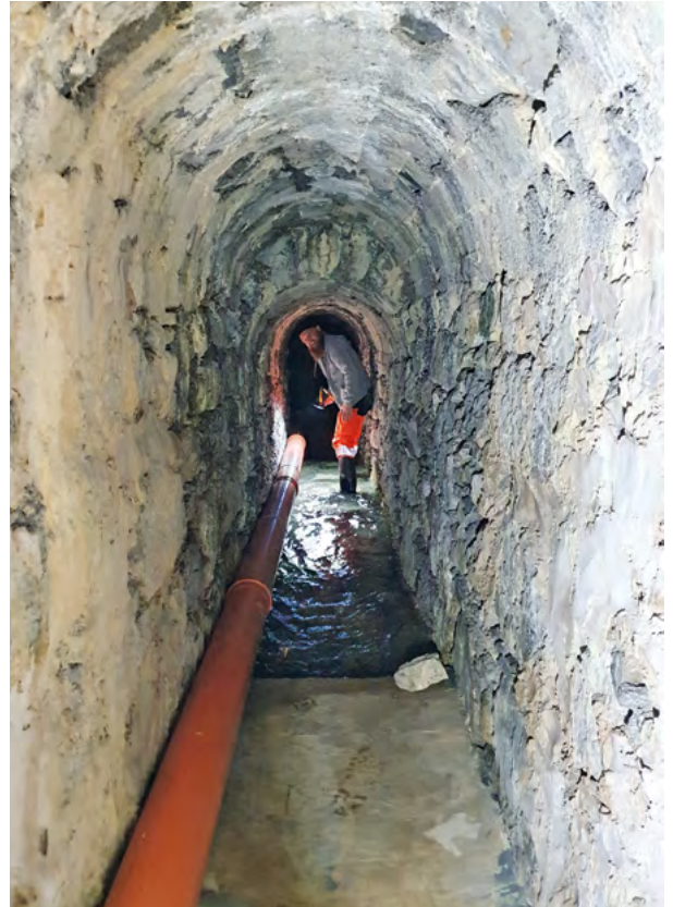
Der Stollen zur Fassung der unteren Galinaquelle
