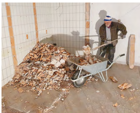
Abbruch der ehemaligen Telefonzellen
