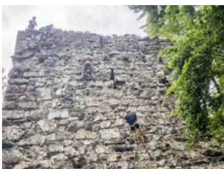
Die Bergrettung Nenzing bei Sanierungsarbeiten im Jahr 2018
