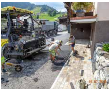
Im Eggweg werden die privaten Vorplätze asphaltiert.
