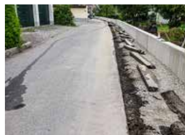
Das Fundament und die Mauer für den Sichtschutz sind fertig.
