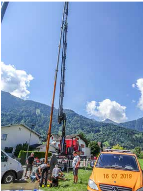
22 Meter misst die Rohrleitung, an der die Pumpe hängt. Nur große Krane schaffen das.
