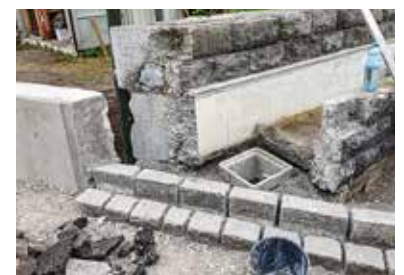
Der alte Steinbrunnen musste der neuen Straßenbreite angepasst werden.
