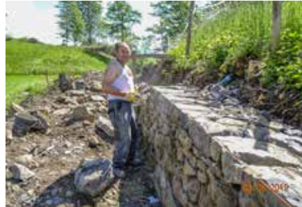
Stipo Pranjić, ein Meister seines Fachs. Die schweren Abschlusssteine stabilisieren das Mauerwerk. Es darf kein Stein wackeln.
