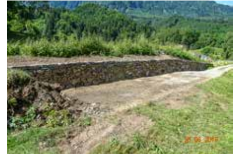
Noch fehlen ein paar Meter, bis die gesamte Mauer fertig ist.
