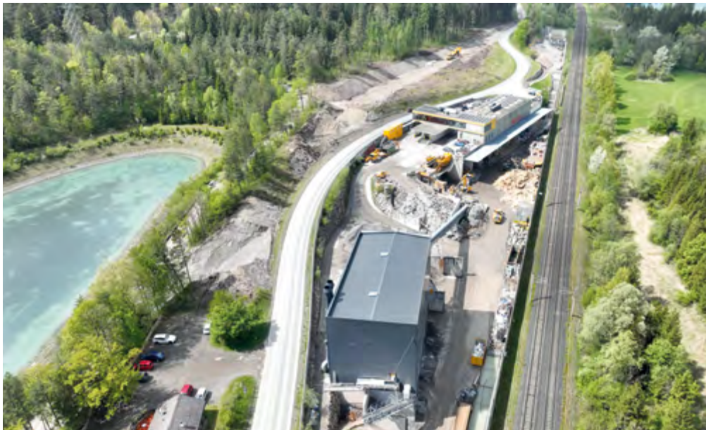
Umlegung der L190 für die Betriebserweiterung der Kessler bewegt's GmbH
