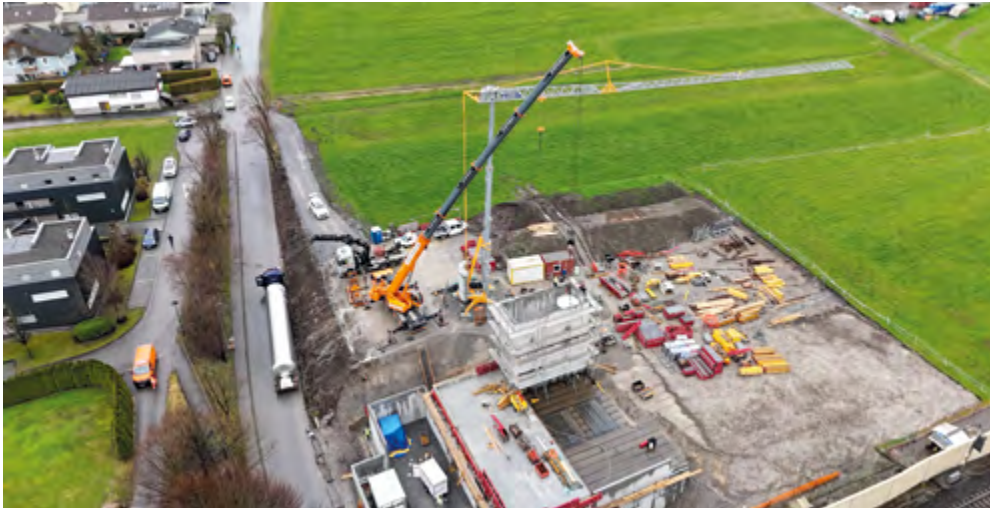
Die beiden Pufferspeicher mit je 55 m 3 Fassungsvermögen wurden per Mobilkran versetzt.
