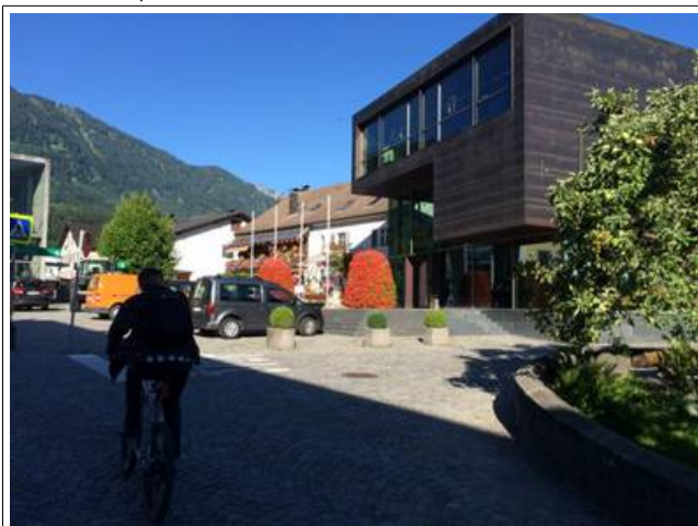
Fig. 5: Die Risiko-Analyse betrifft vorwiegend die gemeindeeigenen Gebäude, im Bild das Rathaus.
